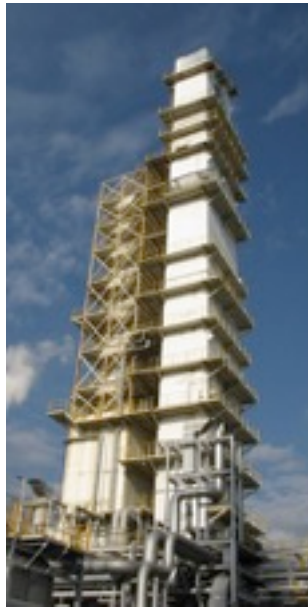
^{18}\text{O} 濃縮プラント 200 kg/年 (千葉サンソセンター袖ヶ浦工場)
