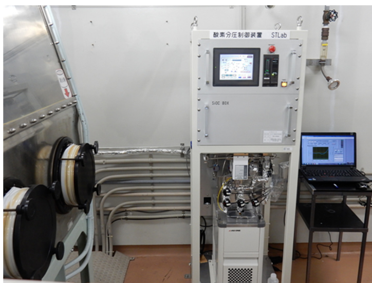
図 3. 2. 4-9 グローブボックスへ接続した酸素分圧制御装置
