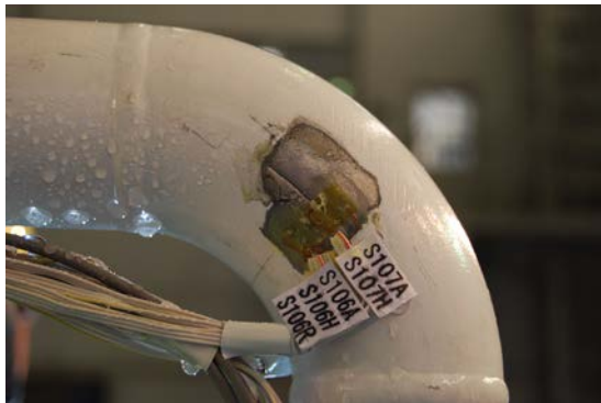
図 3.1.5(2)①-6 SLE02 損傷状況
