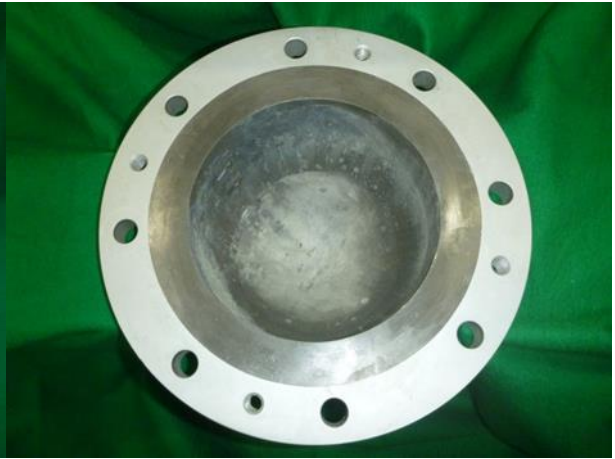
(c) 内面側外観
