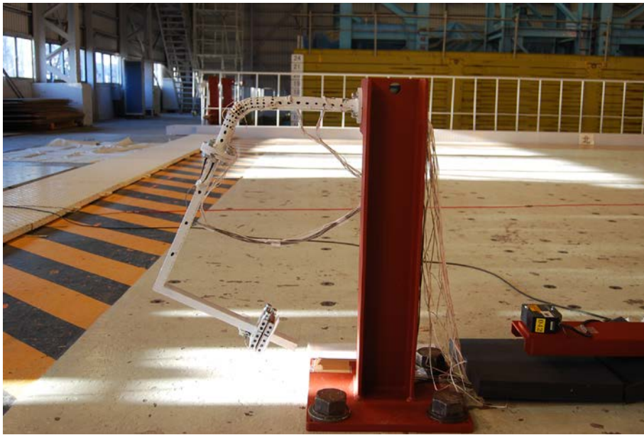
図 3.1.5(2)③-21 SLS_m05 の修復状況 (SLS_m05a 加振前)
