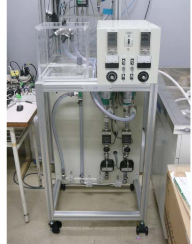
図1 ポンプ診断実験設備の外観
