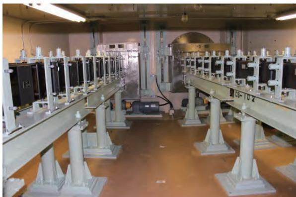
図 3：ビームホール内導管室に据付を完了した新規製作したスーパーミラー中性子鏡管ユニット(奥が上流(炉心側))
